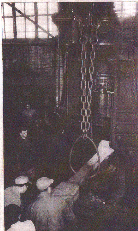
Personal de Macosa trabajando en la forja de bielas, en 1957 (colección Fco. Signes). /LP
