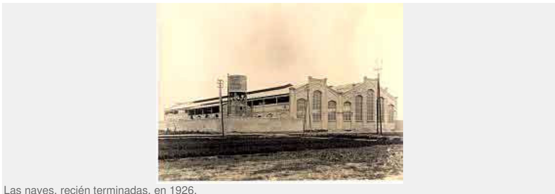
Las naves, recién terminadas, en 1926.
